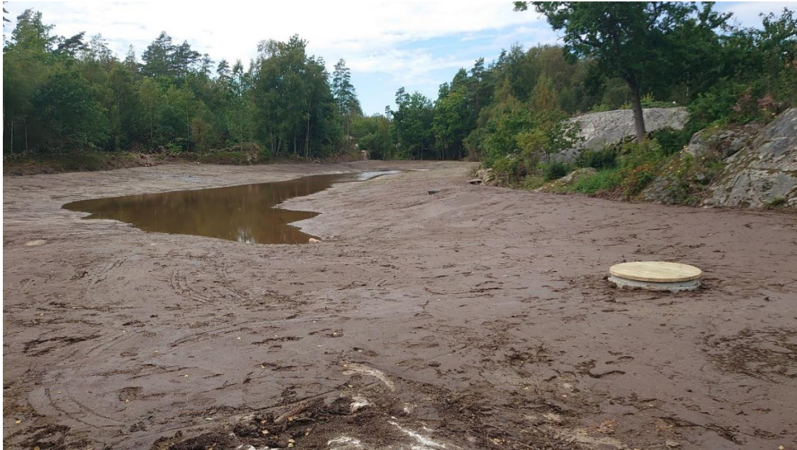
Figur 10. Våtmarken färdig och vattnet börjar fylla upp. I förgrunden syns brunnen med lock av trä. Foto: Kristian Littke, 2023-08-18
