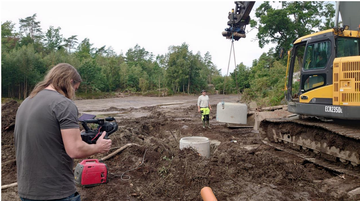
Figur 8. Utloppsbrunnen sätts på plats och vi passar på att få filmmaterial till den kommande informationsfilmen om våtmarksarbetet. Foto: Kristian Littke, 2023-08-15
