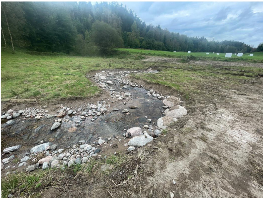
Figur 4. Liknande återskapad strömvattenmiljö på tidigare kulverterad sträcka. Fåran vid Forshälla kommer att bli liknande men något mindre i och med det mindre tillrinningsområdet.
