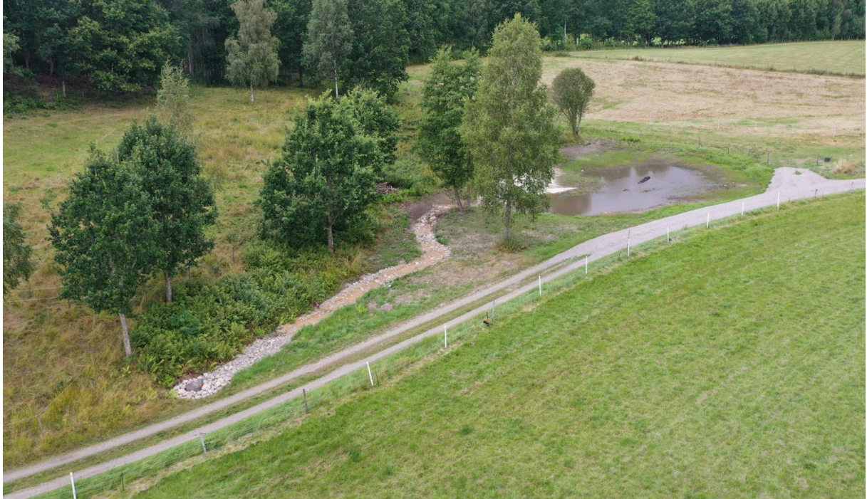
Figur 5: Drönerfoto över den restaurerade dammen i augusti 2025. Dammen har på bilden ännu inte fyllts upp med vatten till den nivå att det rinner över tröskeln och genom det stenlagda utloppet. Foto Kristian Littke.
