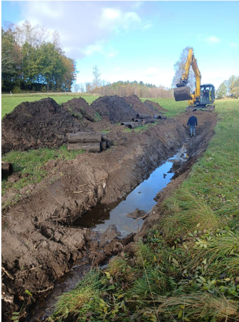
Figur 5: Upptagning av kulvert och grävning av ny bäckfåra. Foto Kristian Littke, 8+ffjordar (2025-10-08)
